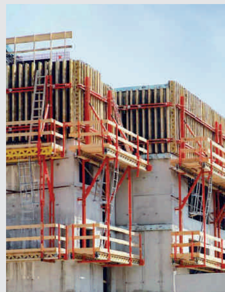
Seguridad Escaleras PERI para un acceso seguro a la plataforma de terminación.
