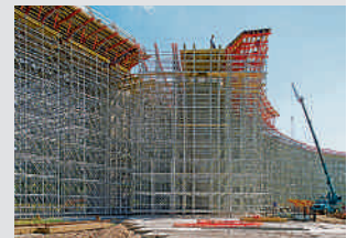
Cimbras y torres de carga
