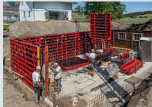
Encofrados para muros
