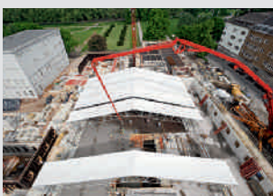
Andamios de protección
