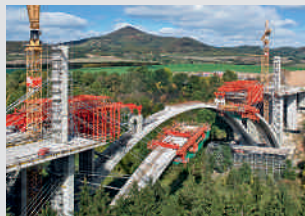
Encofrados para puentes
