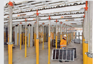
Encofrados para losas
