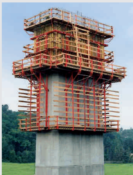
Pilas de puente Hormigón visto con CB 240 y VARIO GT 24.
