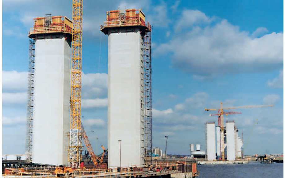
CB 240 con VARIO GT 24 en la construcción de pilas de puente.
