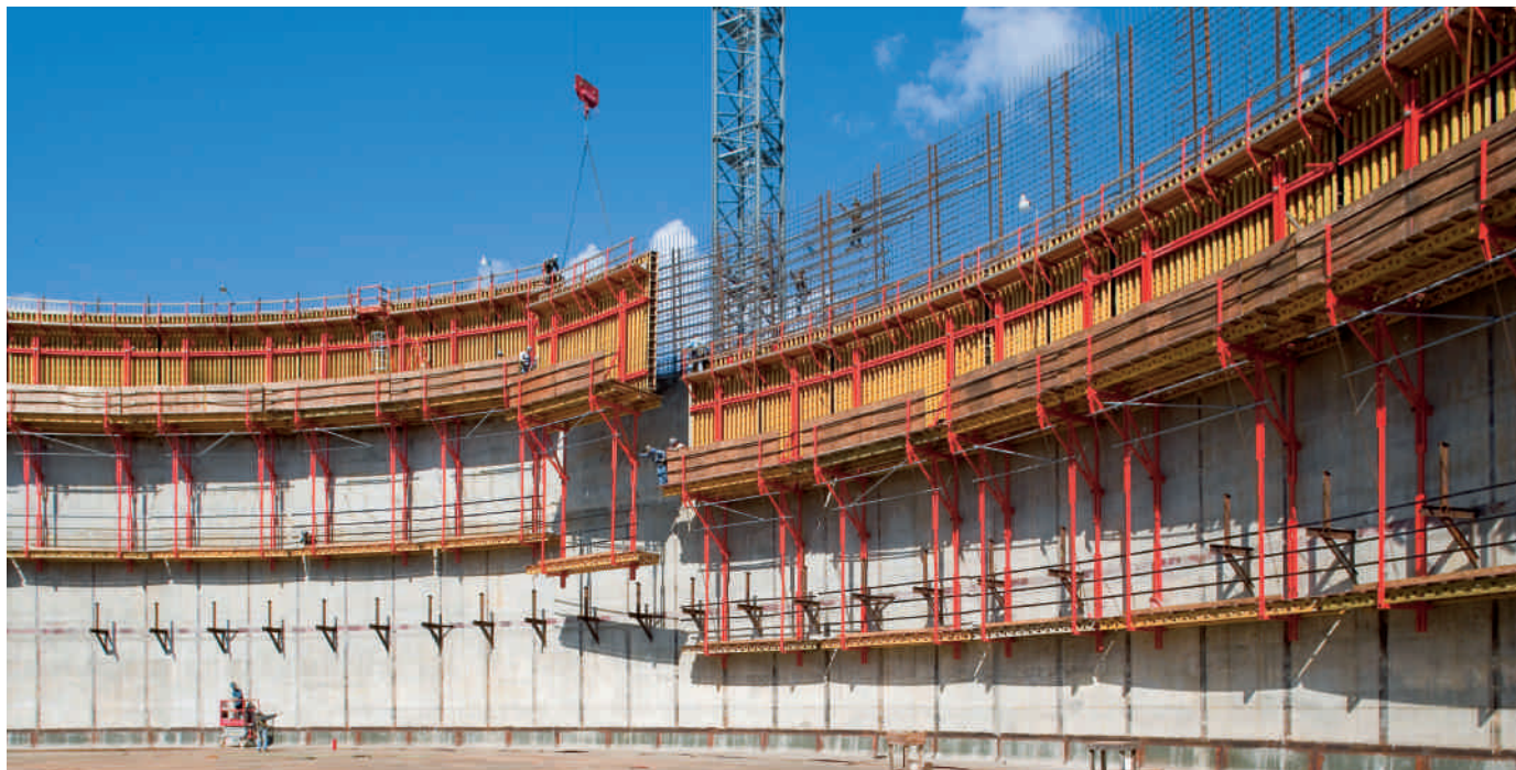
Tanques de gas licuado GNL Muros circulares de Ø 77,50 m con CB 240 y VARIO GT 24.
